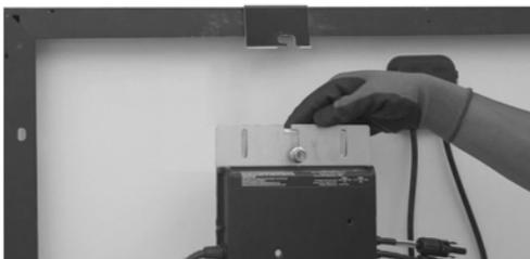
3. Deslice el microinversor hasta la abrazadera del soporte y, a continuación, muévala ligeramente hacia la izquierda. El tornillo de cabeza sujeta ahora el montaje en bastidor a la abrazadera del soporte. La brida de montaje del microinversor deberá estar en el exterior de la estructura del módulo.
